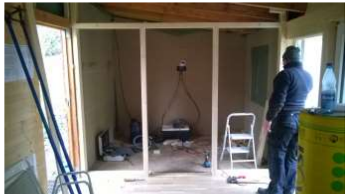
Nach der Entfernung von Balkenkonstruktionen wurde ein neuer Raumteiler errichtet und die Grundinstallation für eine Solaranlage neue angebracht.
