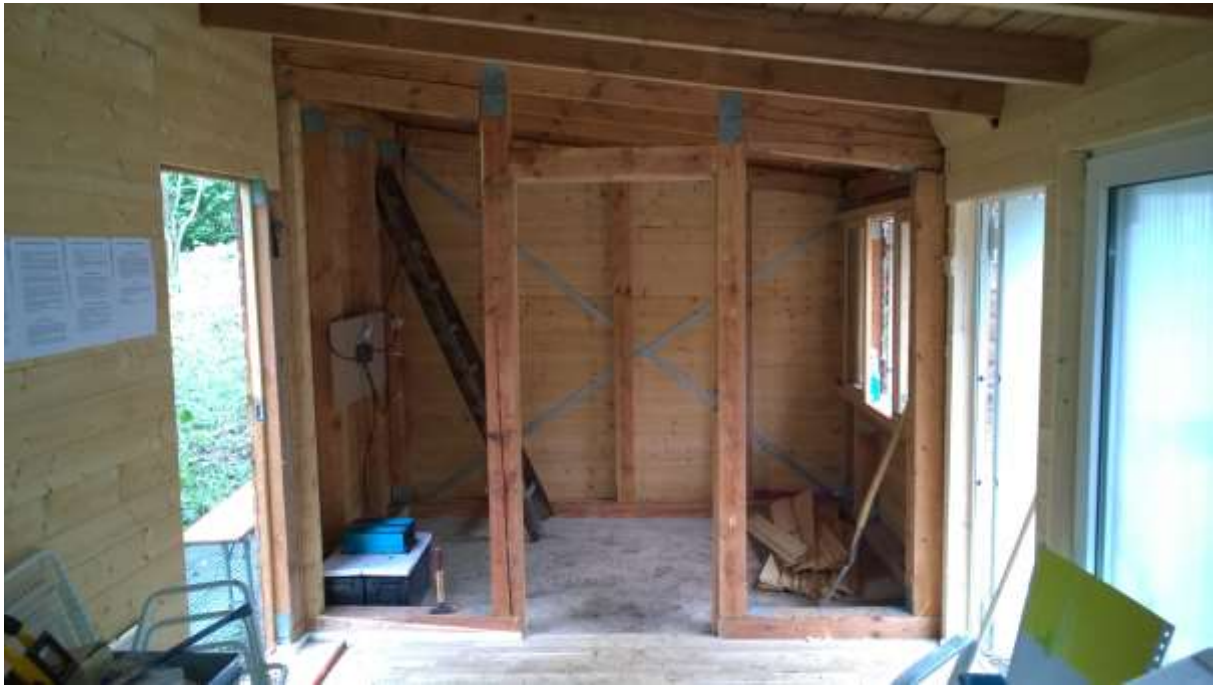
Vor dem Ausbau wurde das Gebäude komplett entkernt.
