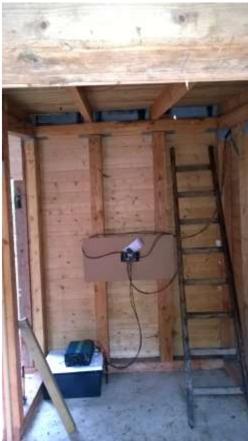
Nach der Entfernung von Balkenkonstruktionen wurde ein neuer Raumteiler errichtet und die Grundinstallation für eine Solaranlage neue angebracht.
